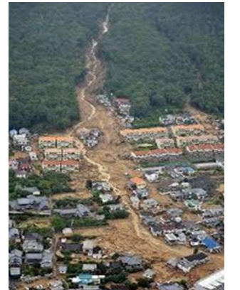
災害発生時、アパートの中を土石流が流れた(参考資料)
